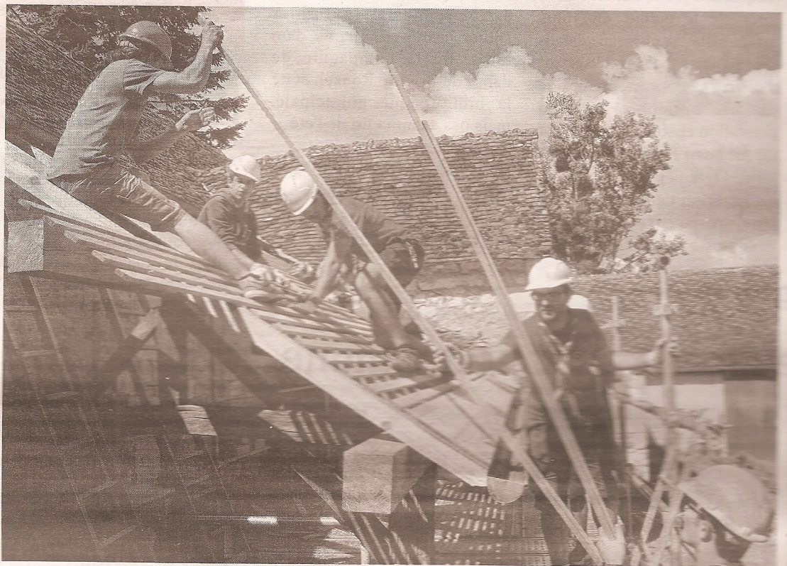
Le travail en équipes a rythmé le séjour des Éclaireurs à Ferrière-sur-Beaulieu. Ici, il s'agissait de refaire la charpente et de remplacer les tuiles par des ardoises.
