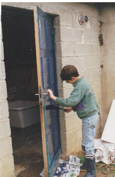
Travaux sur le Bloc sanitaire du Bas-Village
